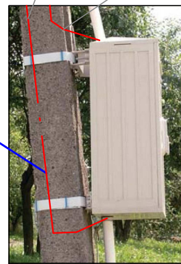
Sposób zamocowania SP/SOU na żerdzi stacji. SOU zabudować ponad istn. złączem kontrolnym uziemienia.
